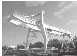
橋形クレーン
